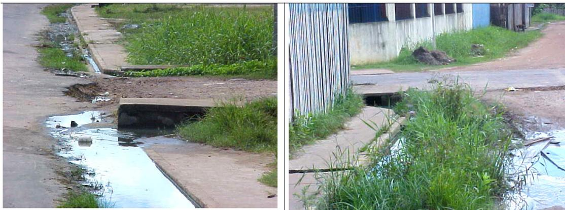
Figura 2 - Registro fotográfico da inspeção in loco da obstrução de sarjetas e bueiros / Moju -2004.
